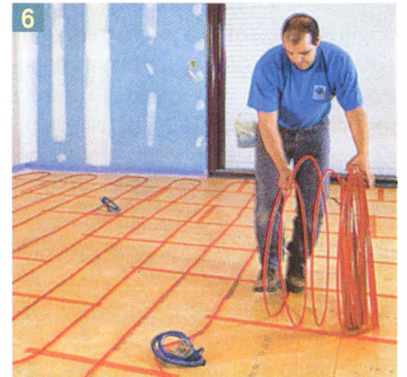
6 Трубки разворачивают сначала вдоль стен, а затем укладывают змейкой по всей площади.
