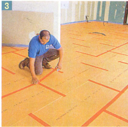
3 После установки панелей их стыки проклеивают клейкой лентой, чтобы избежать теплопотерь, а также для того, чтобы цементный раствор бетонной стяжки не протёк между соединениями.
