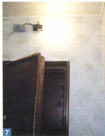
7 Дверь квартиры открывается, срабатывает датчик и лампа загорается.
