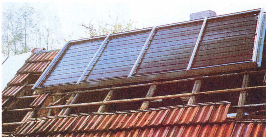
Корпус коллектора с установленной в него сборкой солнечных абсорберов поднимают и крепят на крыше, предварительно сняв в этом месте черепицу.
