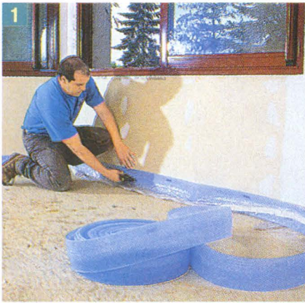
1 Установку тёплого пола на бетонной плите начинают с того, что к стене по всему периметру комнаты крепят строительным степлером полиэтиленовую плёнку.
