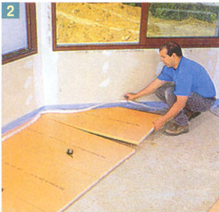
2 Для теплоизоляции пола используют панели пенополистирола.
